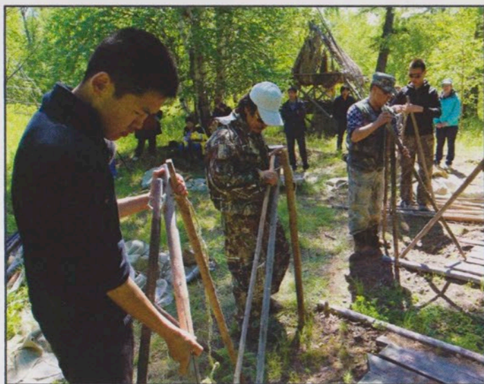
Мастер-класс по строительству юрты
